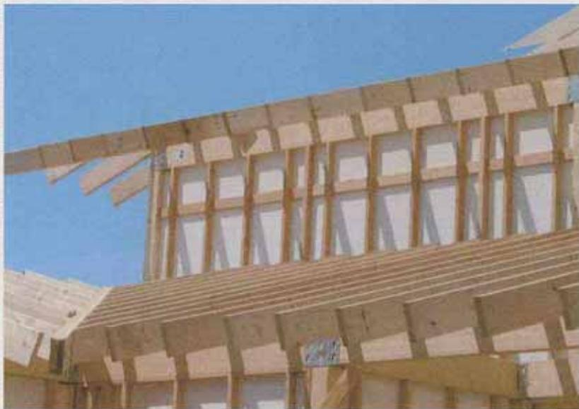
屋根垂木には2\*10が使用され、部材の大きさと施工スピードの速さに周囲が圧倒され完成まで注目されている
